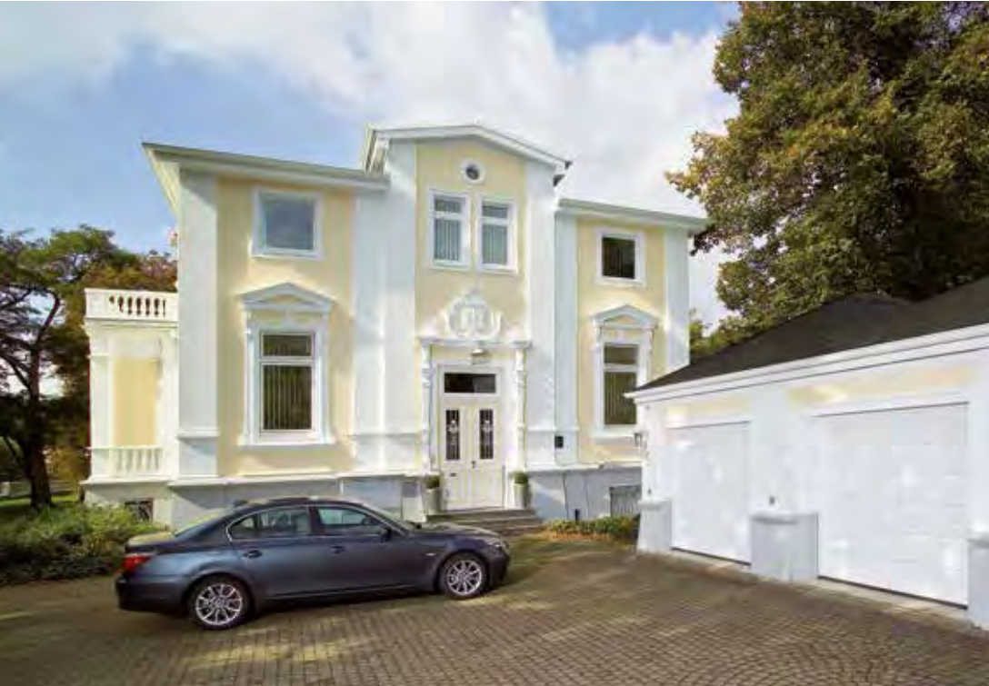
▲ Kasette mit Massivholzpaneelen Hemlock mit Holzlasur in Kalkweiß
