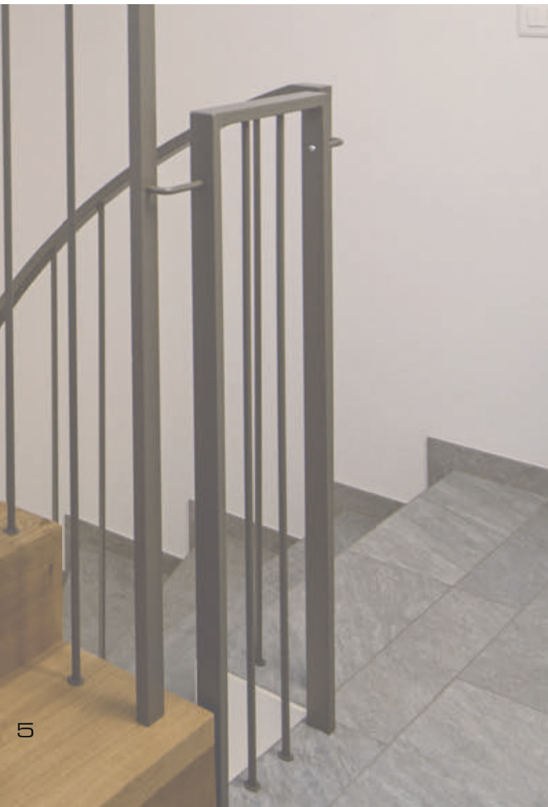
Seite 5: Stufen und Futterbretter in Eiche auf bestehende Betontreppe montiert. Geländer in Flachstahl mit Sprossen.
