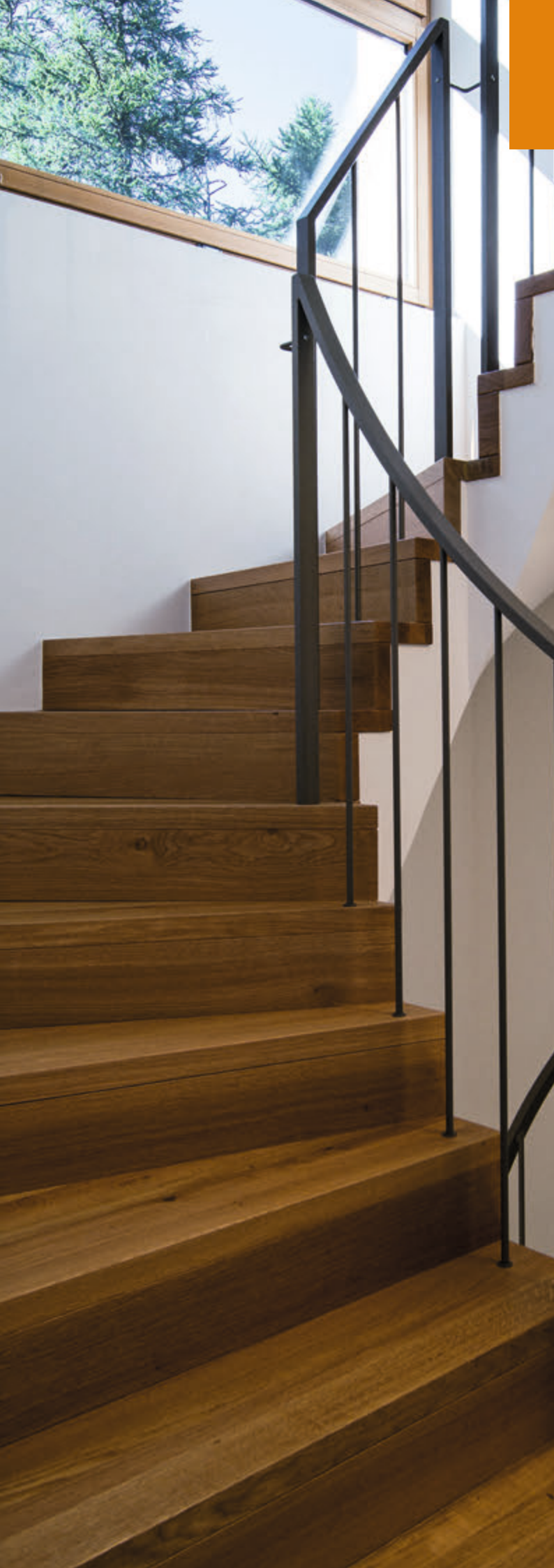
Seite 5: Stufen und Futterbretter in Eiche auf bestehende Betontreppe montiert. Geländer in Flachstahl mit Sprossen.
